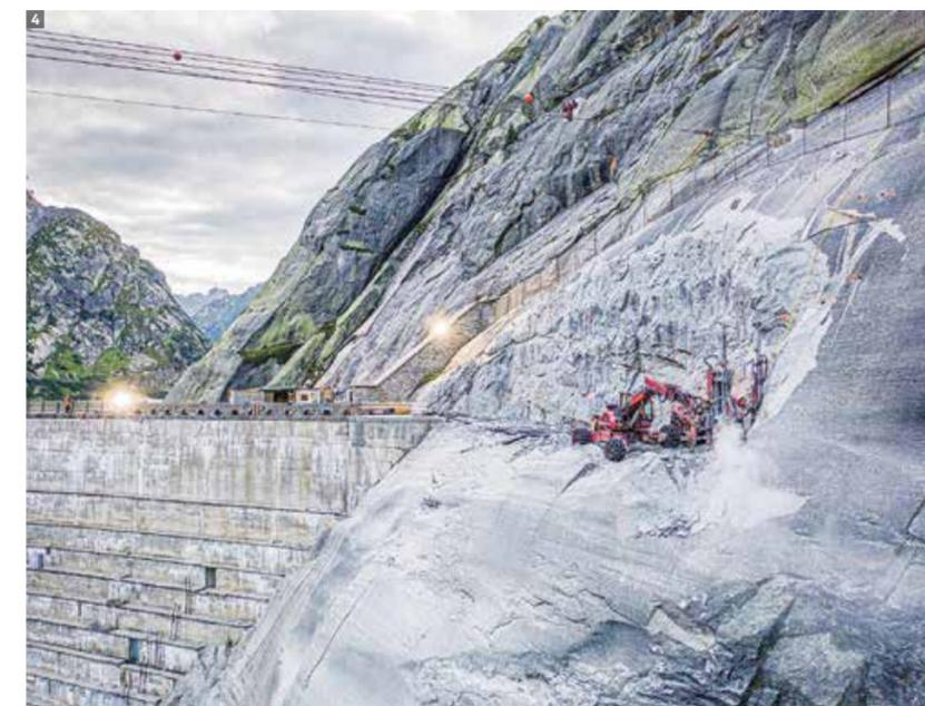
1 Seit Juni laufen die Arbeiten für den Ersatz der Staumauer Spitallamm. 2 Der Leiter Projekte der KWO, Benno Schwegler, kennt die Herausforderungen einer solch grossen Baustelle. 3 Vor der bestehenden Mauer laufen die Vorbereitungsarbeiten für die Betonaufbereitungsanlage. 4 In schwindelerregender Höhe wird der Fundamentaushub vorbereitet und gesprengt. Fotos: David Birri
