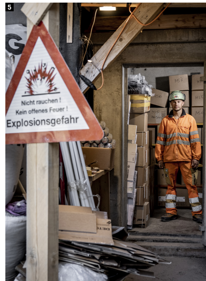
1 Auch Anfang Juni kann es an der Grimsel schneien. 2 Leiter Projekte KWO, Benno Schwiegler 3 Blick auf den fertigen Aushub und die Montage des Kranturms. 4 Chefbauleiter KWO, Ralf Grand. 5 Die Sprengzünder werden in kleinen, sicheren Betonbunkern gelagert. Fotos: David Birri
