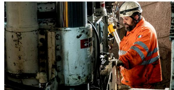
Bei der Staumauer Spitallamm wird derzeit ein 100 Meter tiefer Liftschacht in den Grimselgranit gebohrt.
