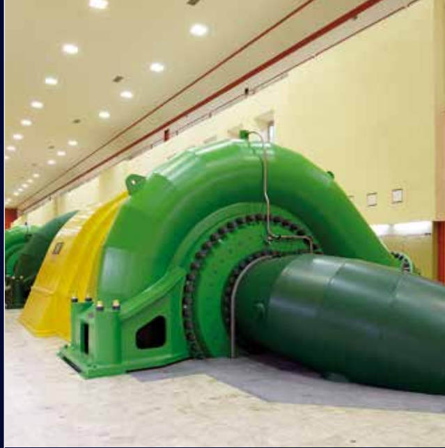
Grimsel 2 – eines der grössten Pumpspeicherwerke der Schweiz
