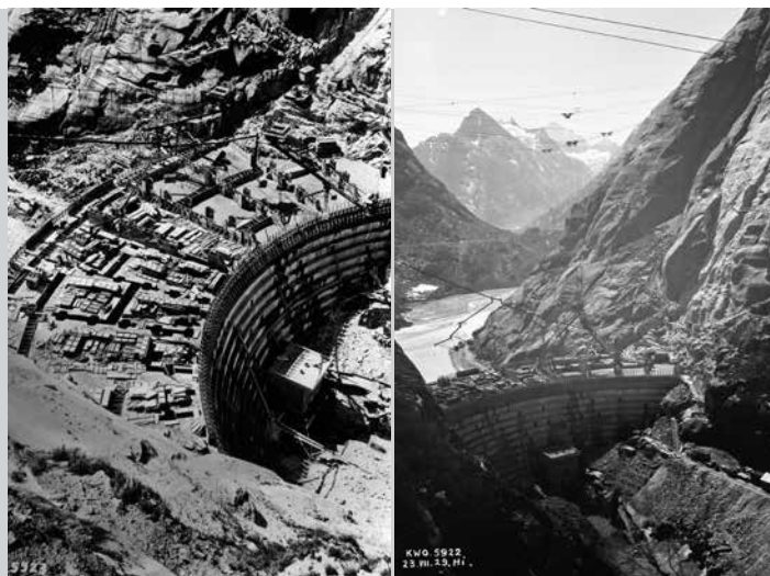
Barrage de Spitalamm ancien: chantier de construction
